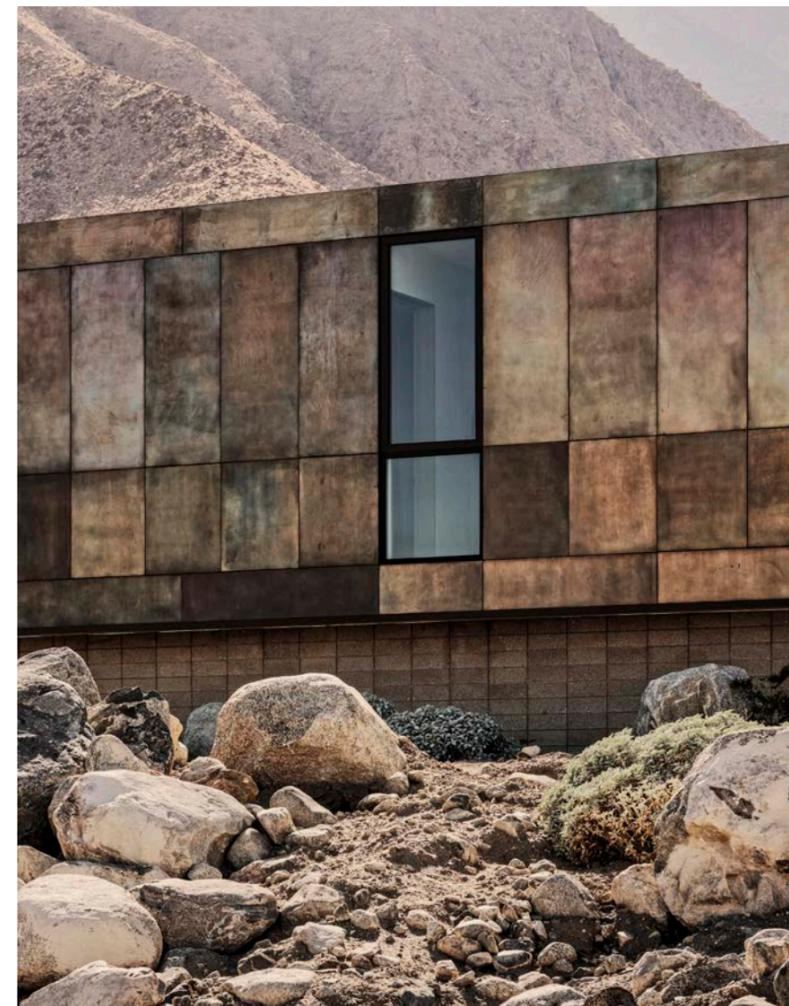
**Plattenbau** Weil sie unbehandelt sind, reagieren die Messingpaneele der Fassade unterschiedlich stark und schnell auf die Witterung
